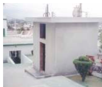
Cabina de força
