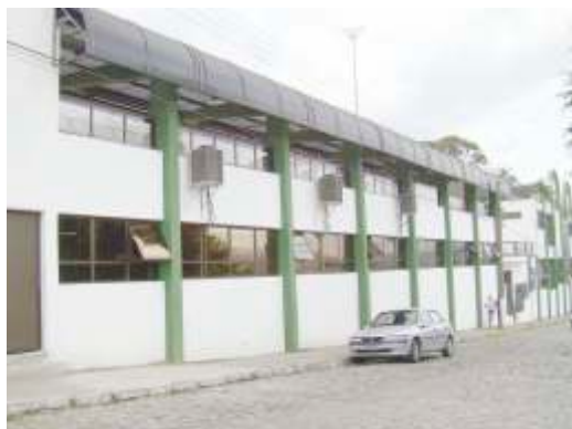
Fachada do Complexo Esportivo, com frente para a Rua D. Bosco.
