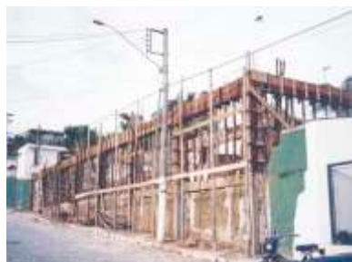
Construção do solário
