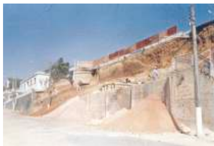
Pavilhão Estácio V.S. Gama. Preparo do terreno
