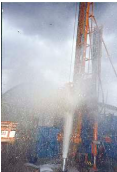
Momento em que a água jorrou do poço.
